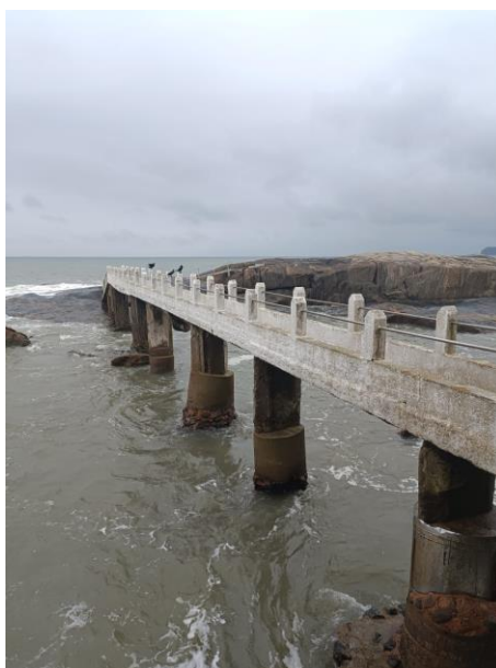
Foto 21 - DECK DE PASSAGEM
